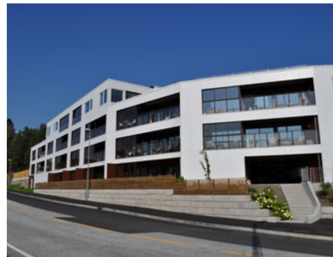
Consto - Basic innglassing og rekkverk
